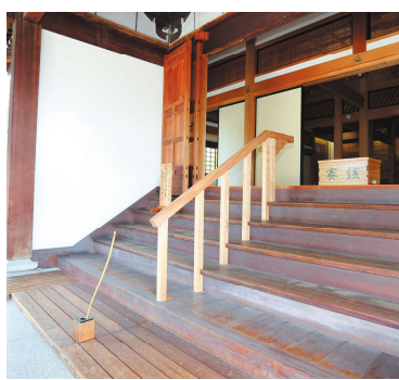
新たに設置した手摺り
