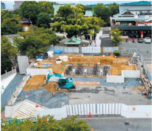
新山門建立工事の様子(令和3年9月12日撮影)
