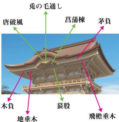
山門上層部の蕨股、葛蒲棟、唐破風、蕨の毛通しの取り付けが完了し、軒廻り造作(木負、地垂木、茅負、飛檐垂木)を行なっております。
